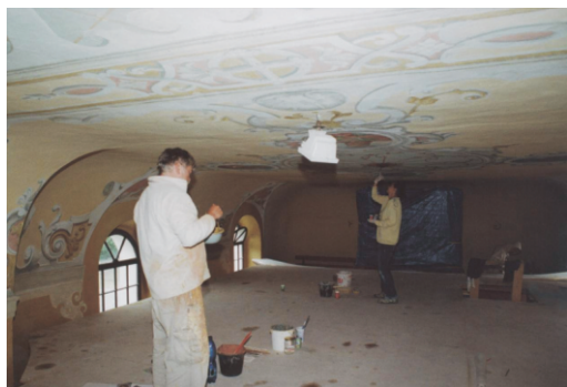
Interiér kostela - restaurování malby
